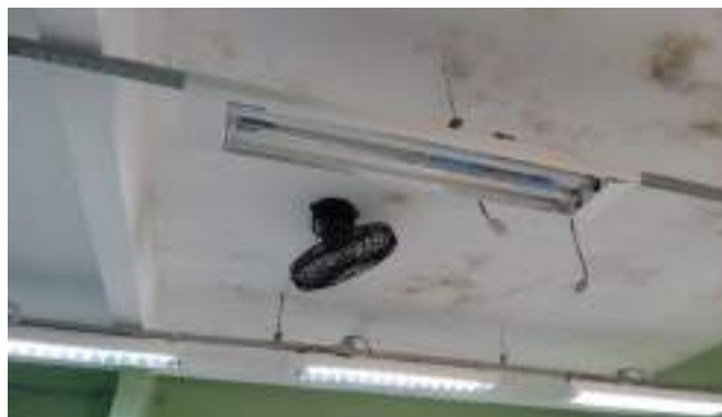
Foto 07 – Teto de sala com infiltração proveniente da cobertura
