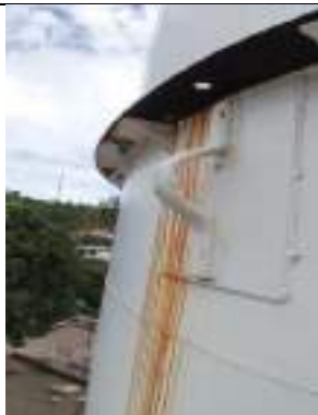
Foto 12 – Ligação entre os compartimentos apresentando pontos de corrosão
