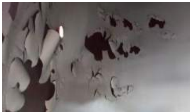
Foto 15 – Parede interna do reservatório inferior com pontos de corrosão
