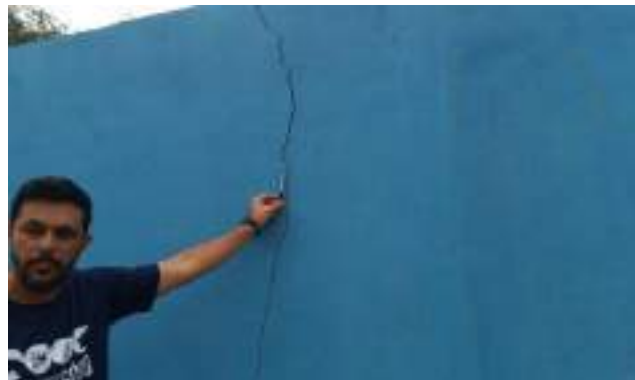
Foto 05 – Trinca no muro
