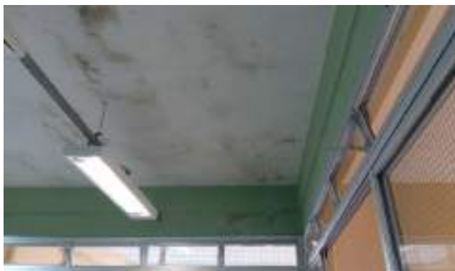
Foto 06 – Teto de sala com infiltração proveniente da cobertura
