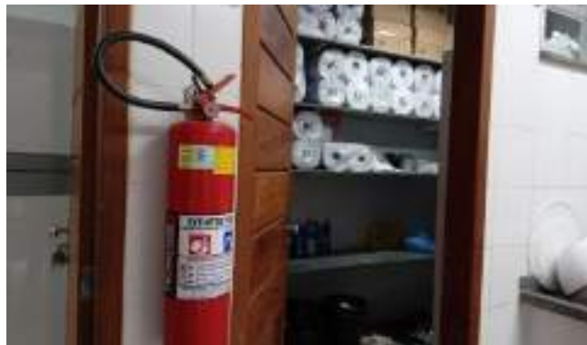
Foto 27 – Extintor instalado na área comum
