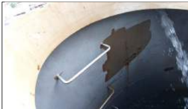
Foto 14 – Parede interna do reservatório superior com pontos de corrosão
