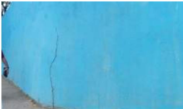
Foto 04 – Trinca no muro
