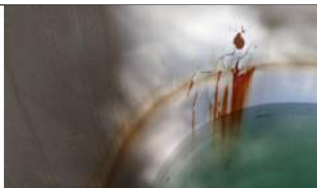
Foto 17 – Parede interna do reservatório inferior com pontos de corrosão
